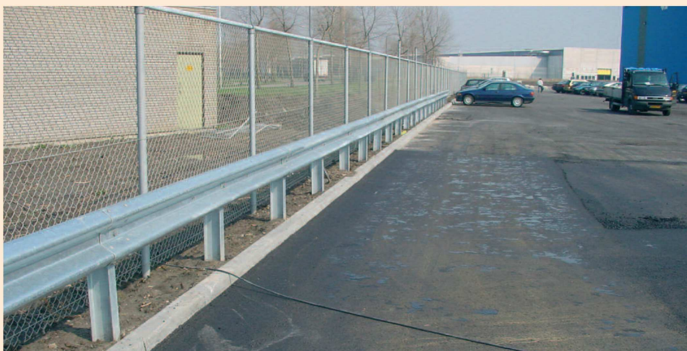
Vangrail A-profiel langs hekwerk
