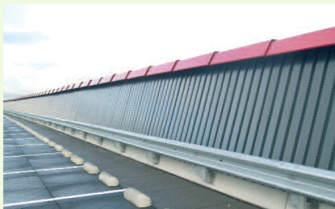
Vangrail A-profiel bevestigd aan wand
