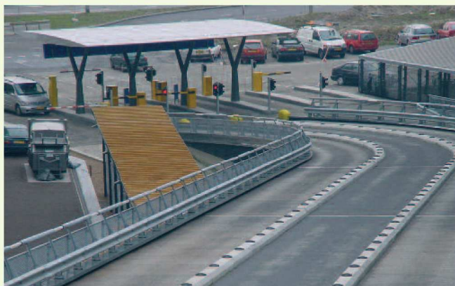
Vangrail A-profiel met hekwerk, leuning en verlichting
