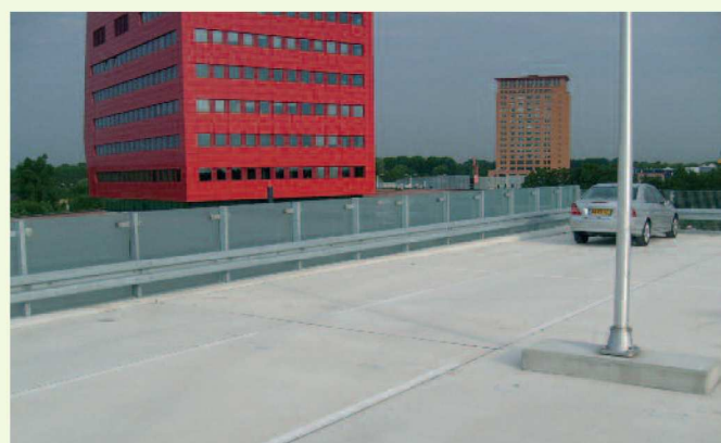
Vangrail B-profiel met hekwerk
