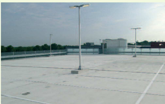
Vangrail B-profiel met hekwerk
