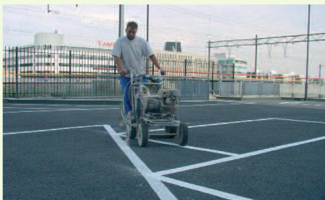
Werk in uitvoering
